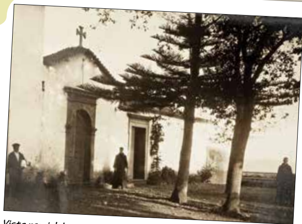
Vista parcial da entrada da Casa de Saúde S. João de Deus, Funchal, Madeira. Década de 1920.
